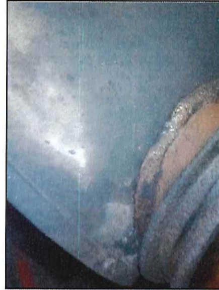
Local: Chassi Item # 36: silencioso do escape quebrado no tubo de saída.
